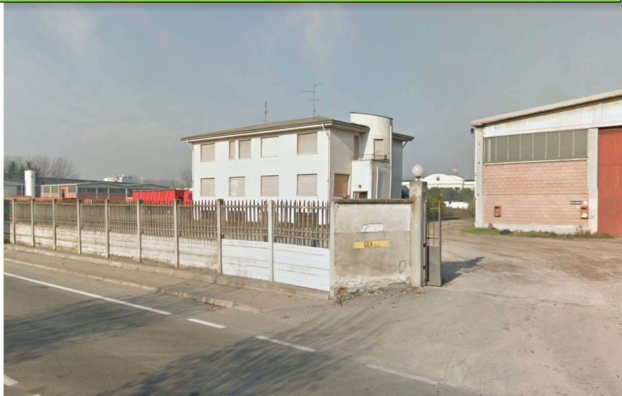
Ingresso da Strada Marziana, 9
