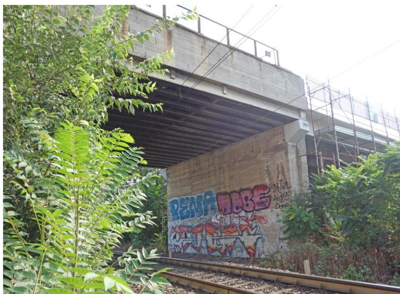
La struttura è costituita da un viadotto in c.a. formato complessivamente da 19 campate che consente l'attraversamento della linea ferroviaria Milano-Alessandria e il collegamento tra il corso Argentina e la via Leonardo da Vinci a Vigevano. L'opera di attraversamento vera e propria è costituita da una travata isostatica formata da 17 travi in c.a. di luce pari a 12,00 m poste ad un interasse di 0,80 m, appoggiate su due setti/spalle in c.a. di tipo continuo.
